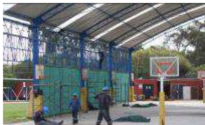
Renovación del techo de la cancha de voley y basquet
