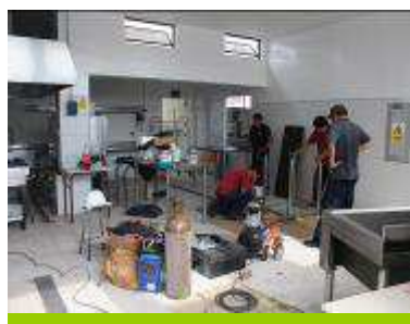
Renovación del material en la cocina del comedor para mejorar la calidad del servicio ofrecido a los alumnos
