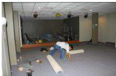
Renovación y mantenimiento de la sala de teatro
