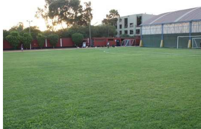
Renouvellement du terrain de football
